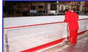
Montage de la rambarde autour d'une patinoire temporaire
