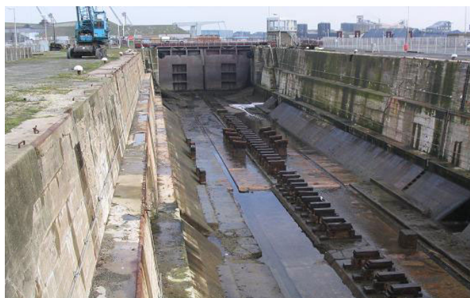
"Illustration 5" Cale sèche du port de Saint Malo Loïck Bourdon
